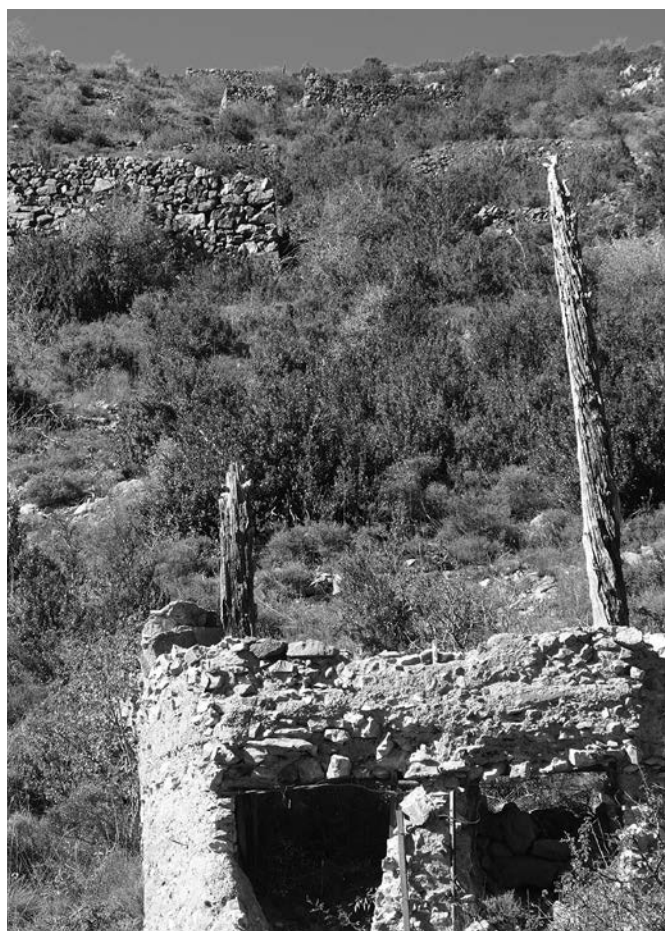
Carregador de peu de mina, on s'hi observen dos pals de fusta, els quals formaven part del sistema d'ascens i descens de les vagonetes. Joan Carles Pereiro Laguarda, 2014.
