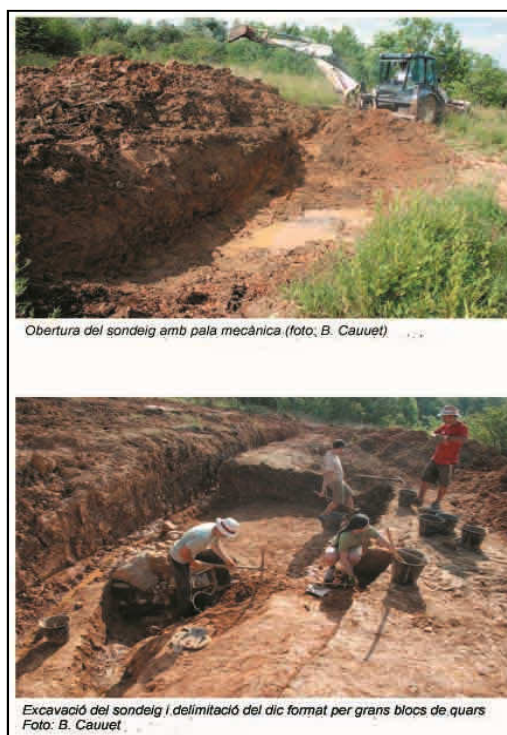
Fig. 20b: La segona rasa efectuada i l'inici dels treballs d'excavació.
