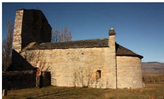
Vista exterior. Santa Maria de Mosoll.
