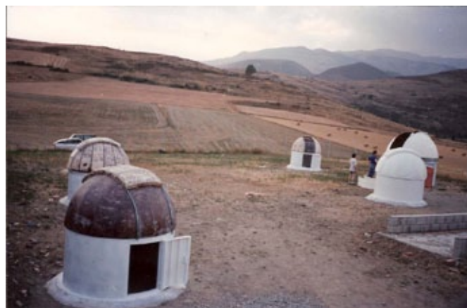
L'observatori fix, en procés de construcció, cap a l'any 1988
