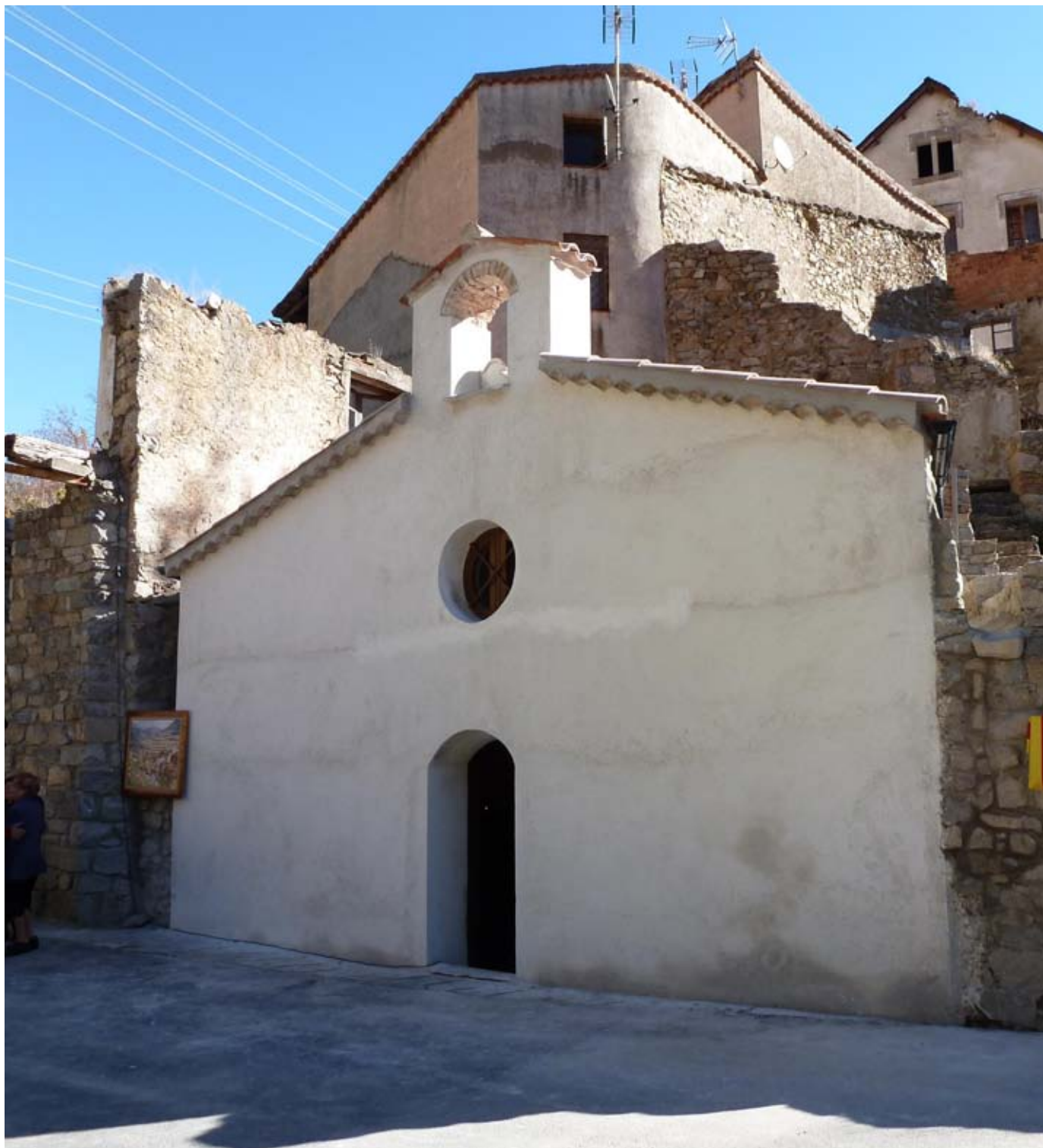
Capella de Pont de Bar rehabilitada. Foto: Lluís Obiols
