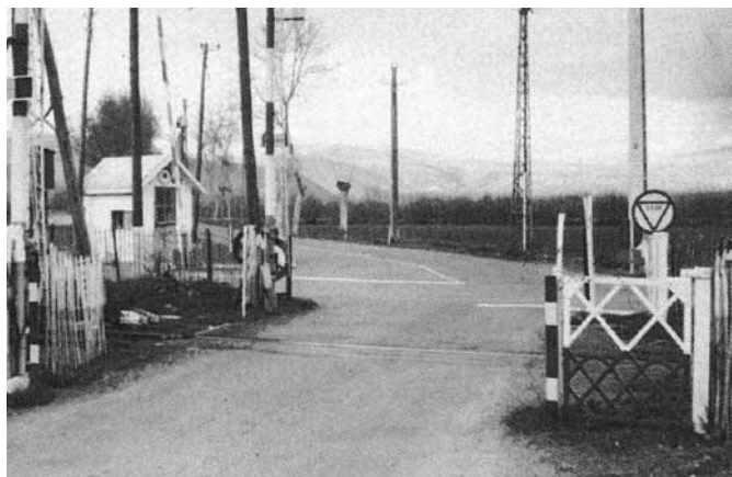
Cruïlla de l'N-20 amb la D-68 i la via del tren groc, abans de la construcció del pas enlairat
