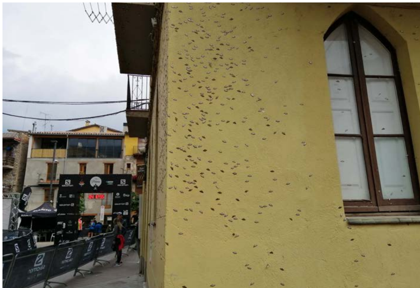
Façana d'una casa de Bagà coberta de papallones del boix el 3 d'octubre de 2021. Autor: Jordi Garcia-Petit
