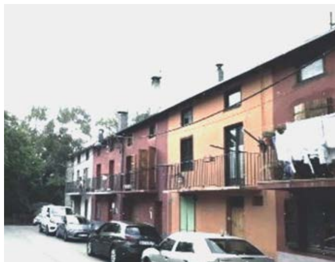
Figura 3. Habitatges particulars actuals de la Colònia Simon. Font: elaboració pròpia
