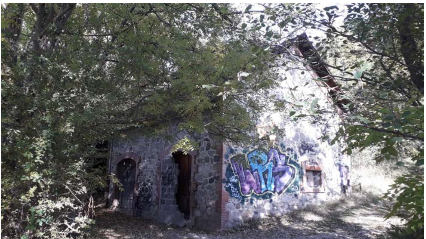
Figura 14. Central elèctrica de la Font del Cúcuru, a Puigcerdà. Font: elaboració pròpia
