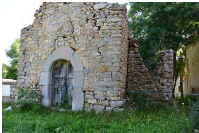
Façana de ponent i de migdia
