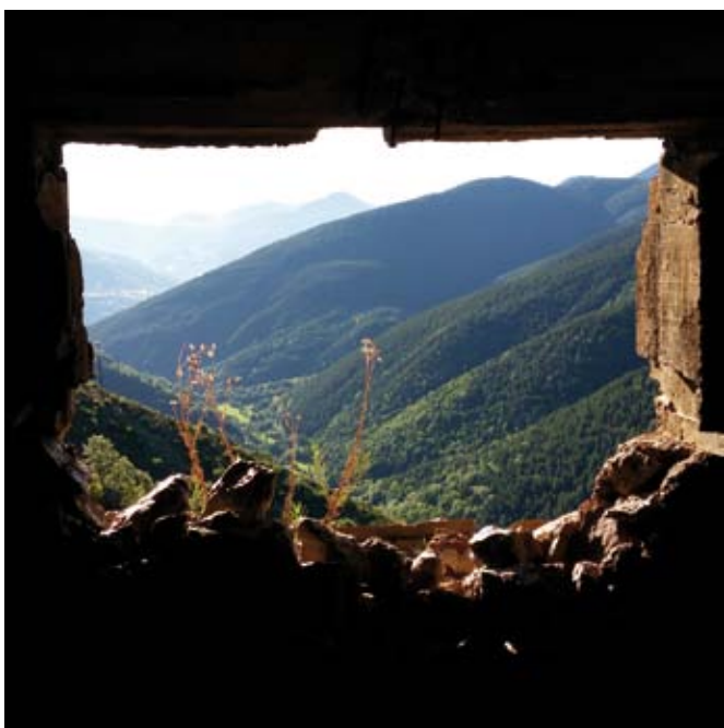
Vista exterior d'un búnquer d'observatori, situat al centre de resistència 53
