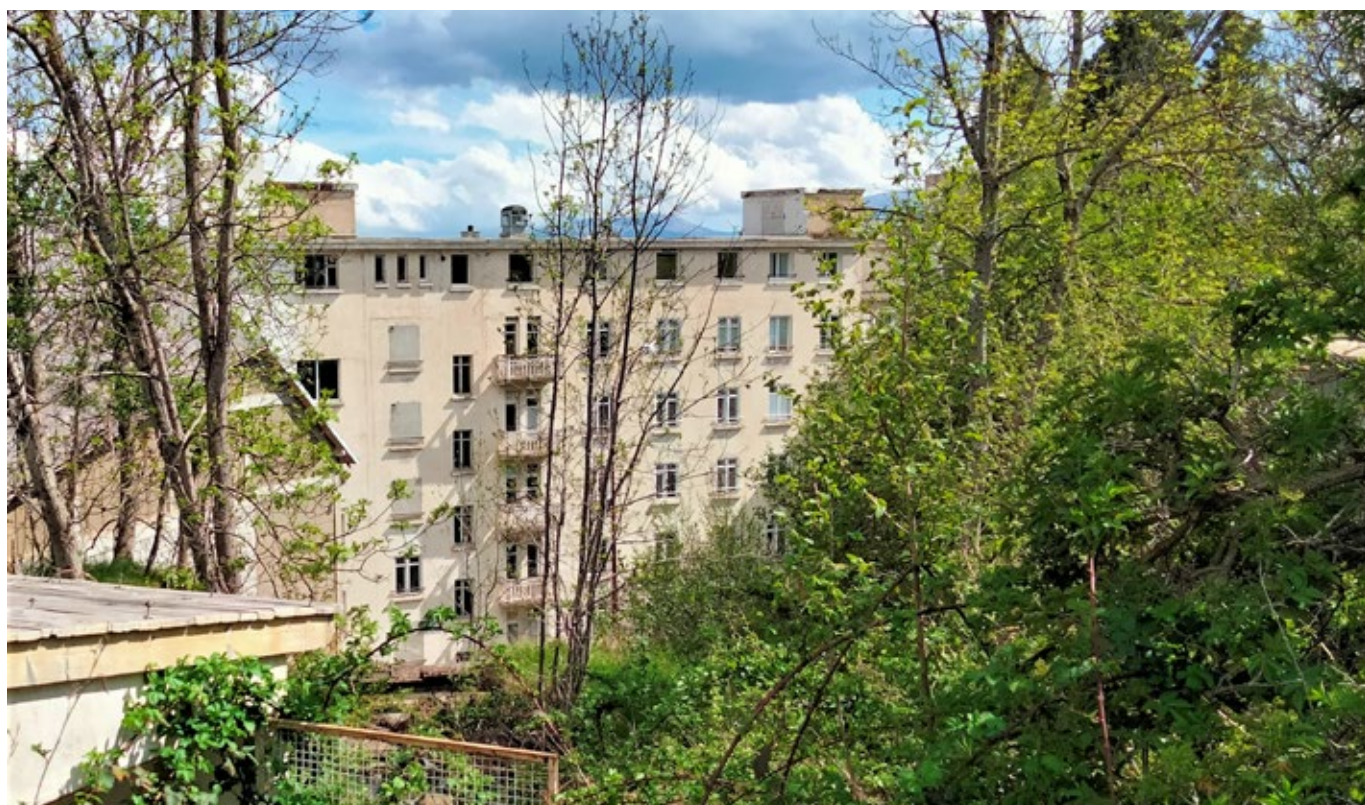
Vista d'un dels edificis del conjunt de Les Escaldes
