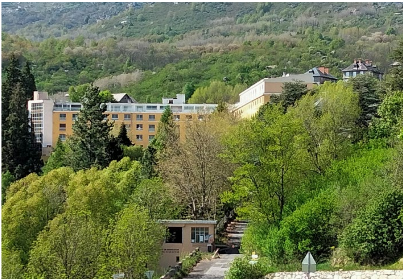
Fig. 1. Vista general de l'antic sanatori antituberculós de Les Escaldes.
