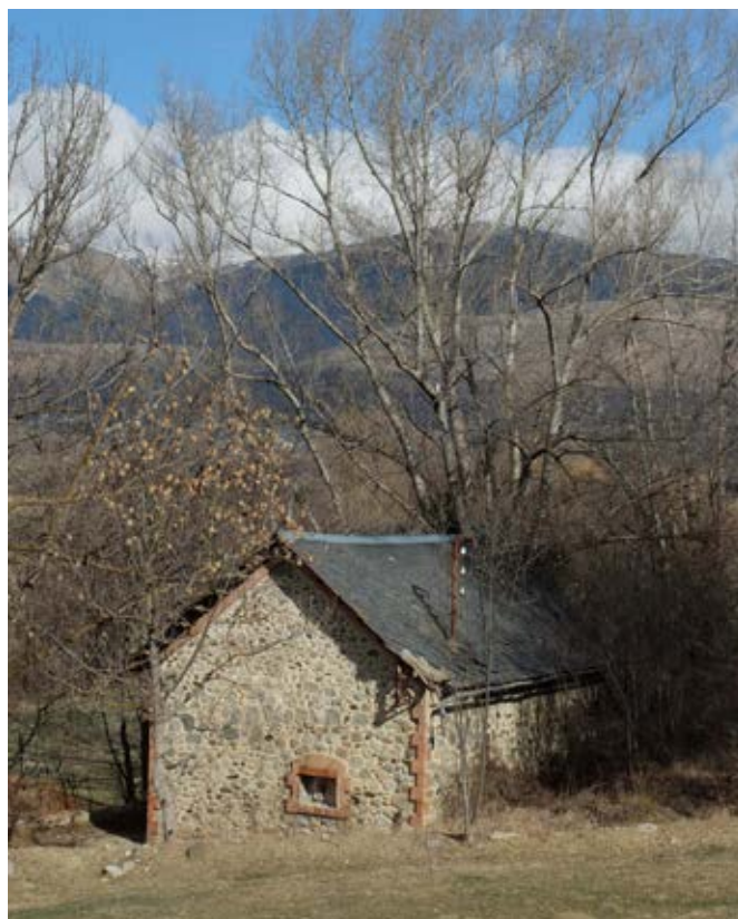
Central elèctrica de Puigcerdà, construïda el 1912. Va estar en servei fins a finals dels anys 20. Foto: Erola Simon.
