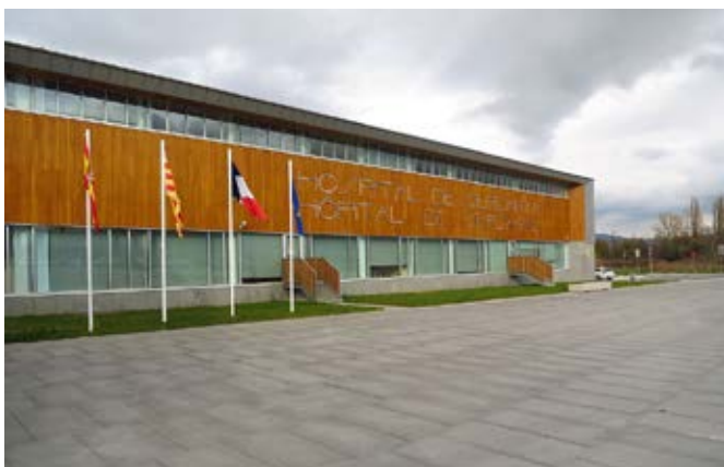
Hospital de la Cerdanya.
