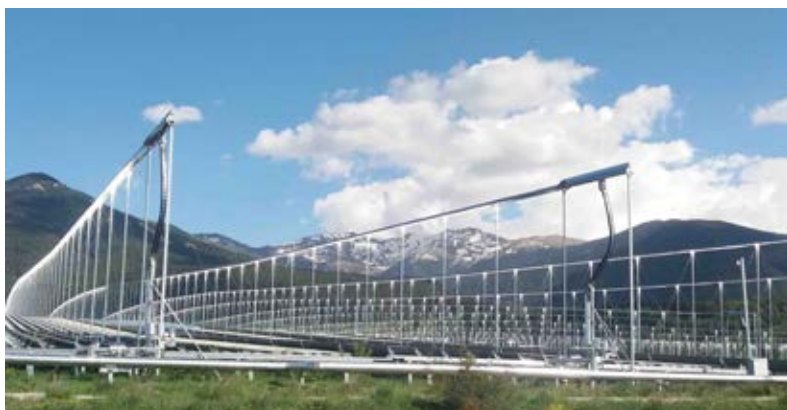
Camp d'heliòstats a la central solar de Llo (eLLO)
