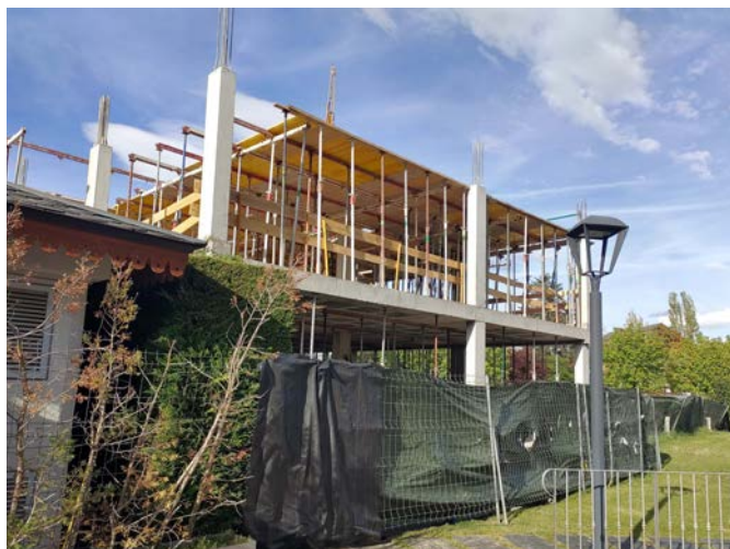
Pisos en construcció.
