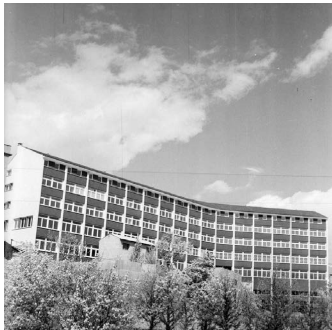
L'edifici antic dels escolapis a Puigcerdà i l'edifici de nova construcció a partir dels anys 60 (actual Institut Pere Borrell). Fotos. Arxiu Comarcal de Cerdanya
